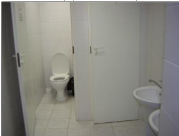
Фото 6 Оборудование санузлов: сантехническое оборудование – современное, в хорошем состоянии
